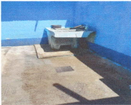
Foto 7: Mantenimiento a reposadera
