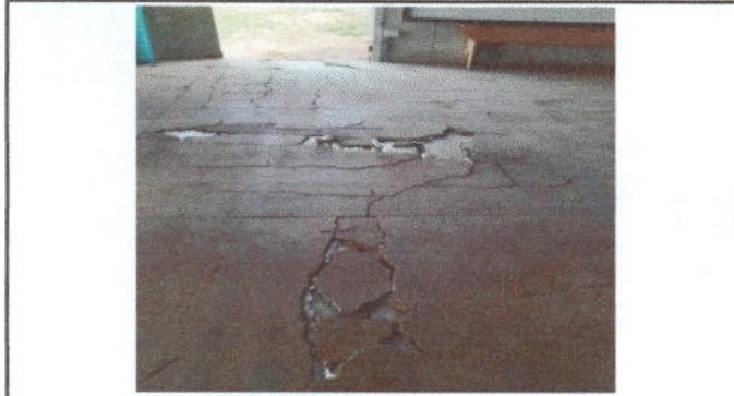
Foto 1: Sustitución de piso prefabricado por torta de concreto
