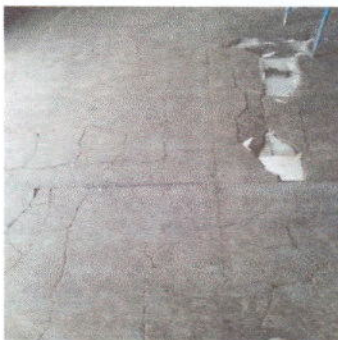
Foto 11: Sustitución de piso prefabricado por torta de concreto
