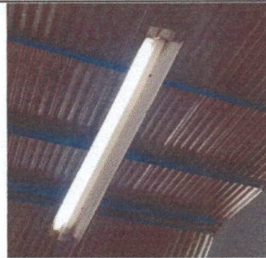
Foto 8: Sustitución de lámpara de 2 x 40
