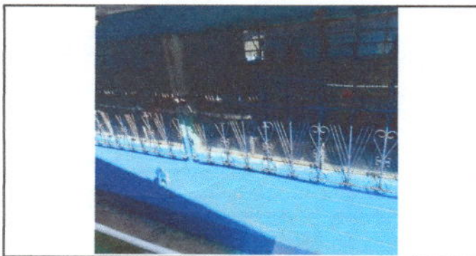
Foto 5: Mantenimiento a balcones de metal
