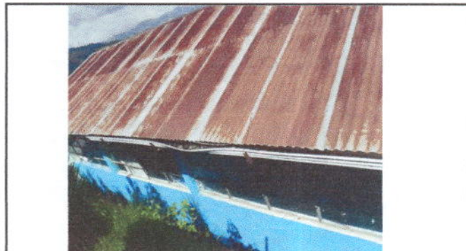
Foto 4: Sustitución de canal pvc
