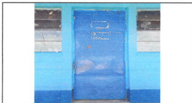
Foto 6: Mantenimiento de puertas de metal
