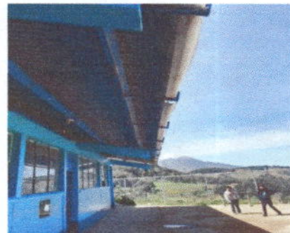
Foto 12: Sustitución de canal PVC
